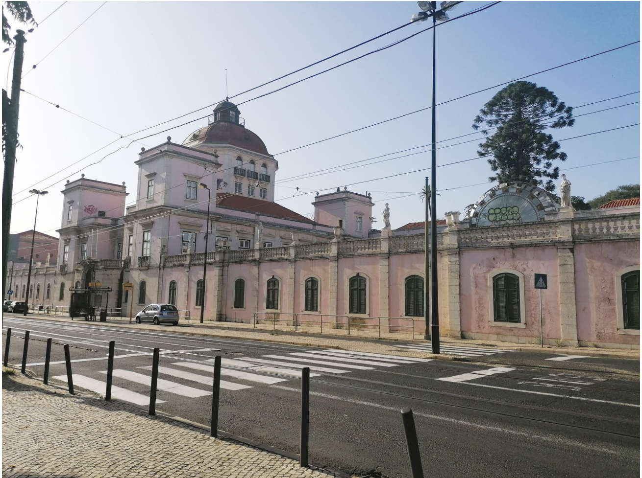
Fig. 2 Fachada principal do Palácio da Junqueira. Fotografia do autor. 2022.
